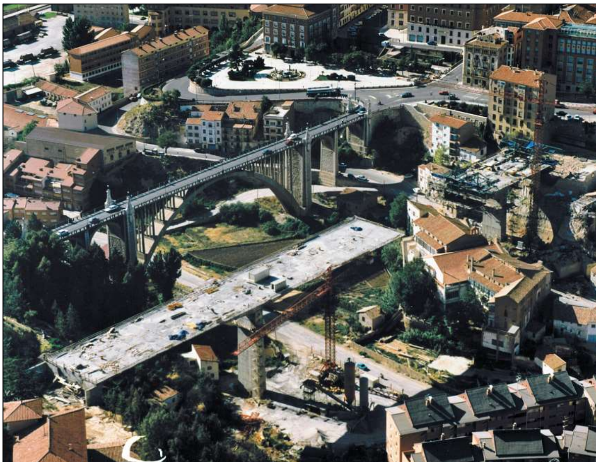
Viaducto Nuevo, en construcción.
