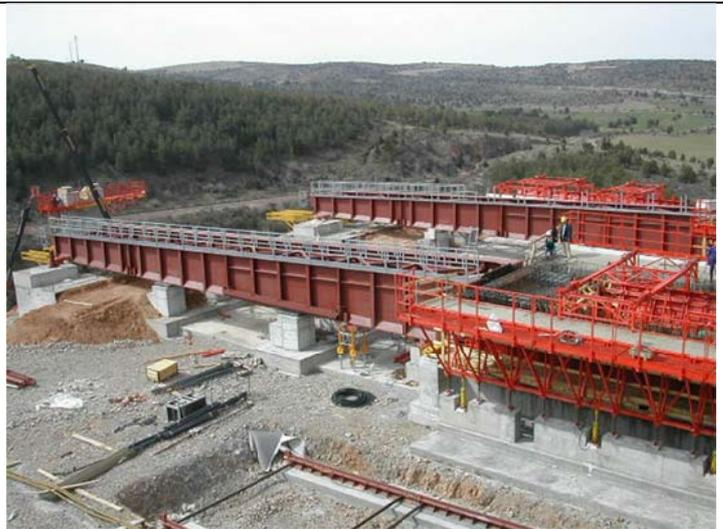
Parque de construcción de dovelas del tablero (viaducto "José Torán"; A-23). Pescante de lanzamiento.
